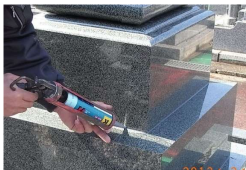
免震ボンド目地の施工
