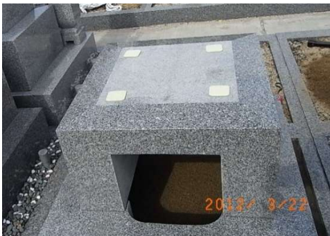
免震マットを各台座に使用
